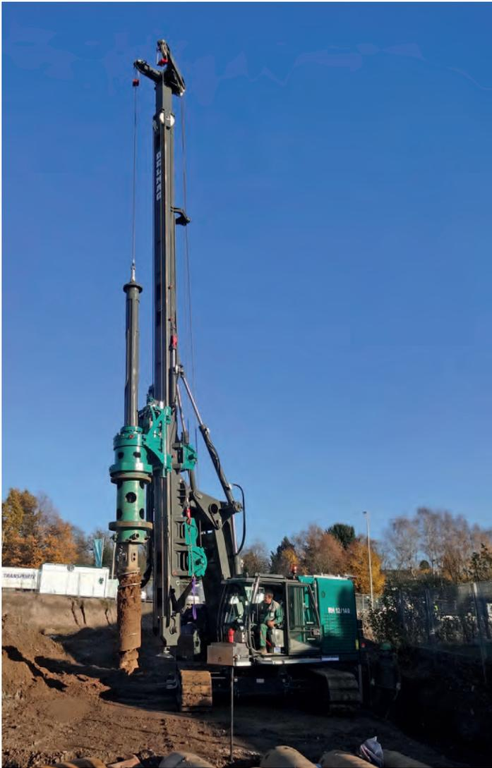
*Bild: RH 12/140 der Firma S+H Spezialtiefbau, Baunummer 1, mit Kellybohrantrieb BT 140 in Bonn-Beul beim Abschleudern des Bohrgutes*
