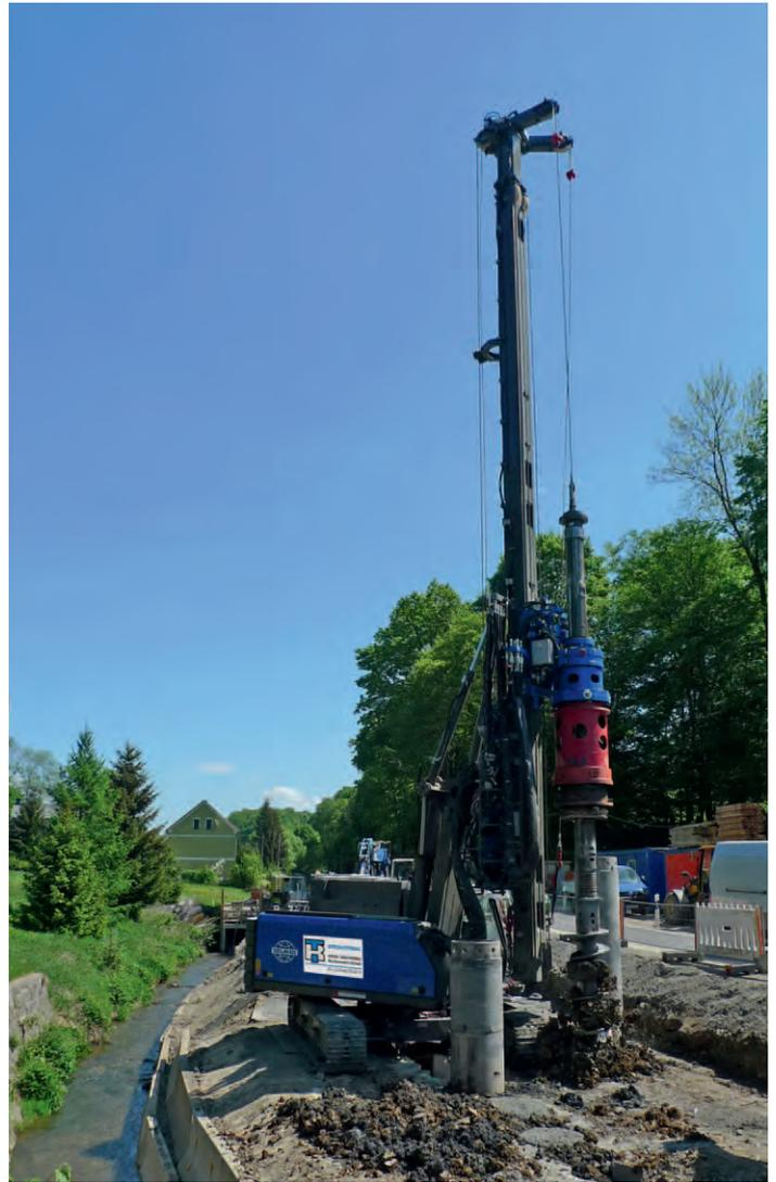
*Bild: RH 12/140 der Firma Hoch- und Tiefbau Reichenbach, Baunummer 2, bei Kellybohrarbeiten entlang des Wildenfels Baches*
