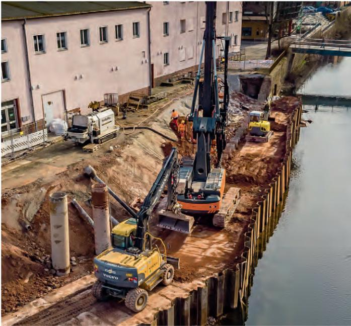
Die Drehbohranlage bohrte ca. 130 Pfähle mit einem Durchmesser von 880 mm im Kellybohrverfahren. Der Kellybohrantrieb arbeitete sich mit einem Drehmoment von 270 kNm mühelos durch die Bodenschichten bis zur Endtiefe von 12 m. Die fertiggestellte Bohrpfahlwand wird mit einem Stahlbeton-Kopfbalken versehen und anschließend mit Natursteinen verkleidet.
