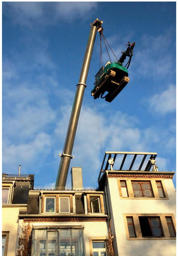
*Bild: DELMAG Drehbohranlage RH 06 wird über die Häuserfront in den Hinterhof gehoben*
